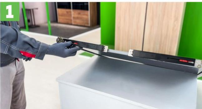
На одну дверь устанавливается два доводчика, они будут работать на открывание и закрывание каждой стороны двери. Если ширина двери менее 670 мм, вы можете поставить только один доводчик, в таком случае он будет работать только на закрывание
