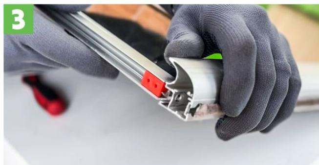
Сдвиньте ручку и установите фиксатор в верхнюю планку двери
