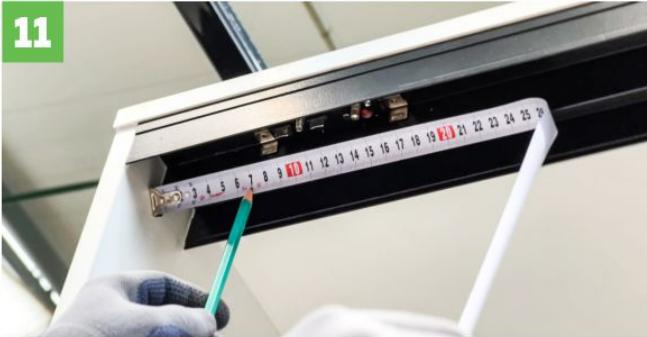
На расстоянии 70 мм от боковой стенки шкафа, в зависимости от расположения двери, установите активатор доводчика в верхнюю направляющую при помощи саморезов по металлу
