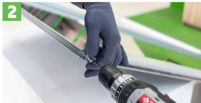
Ослабьте евровинт со стороны установки доводчика, изымите ролик, а затем полностью выкрутите его.
